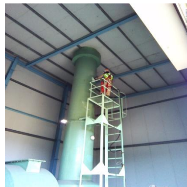
ปล่องจาก Wet Scrubber ของหน่วยชุบเคลือบ ลูกรีดเพื่อการซ่อมบำรุง (Chromium Plating)
